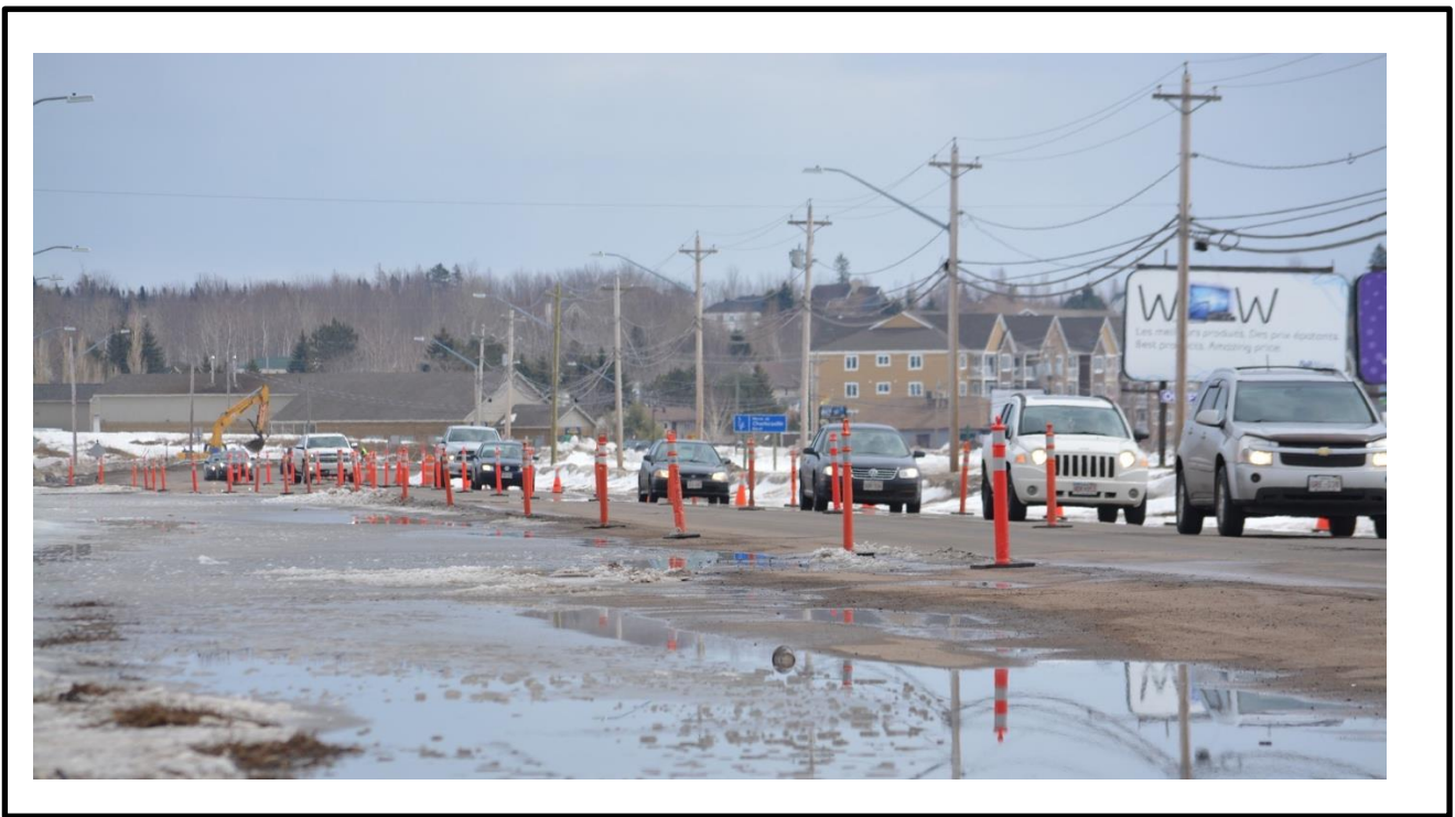
Figure 9. Inondations sur le Boulevard Dieppe (Doiron, 2015).
